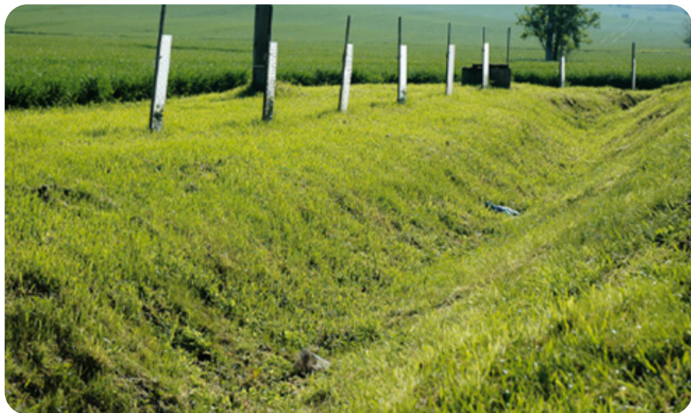
Фиг. 2: Затревена ретензионна канавка, проектирана в Чешката република (Dzuráková et al., 2017).
