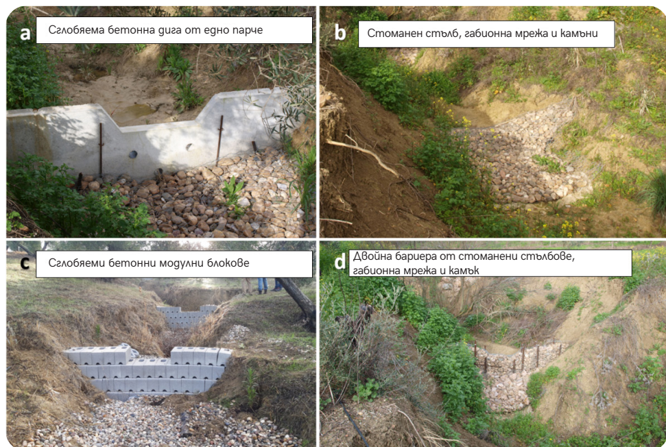
Фиг. 1: Диги, контролиращи деретата с различни техники на изграждане.
