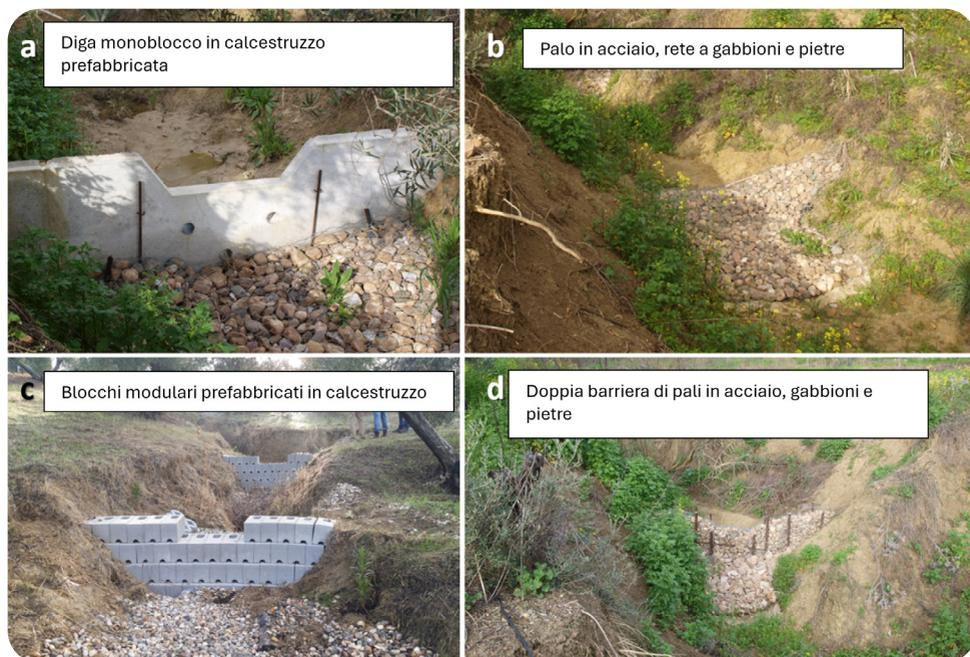
**Fig. 1:** Dighe di controllo dei canali con diverse tecniche costruttive.
