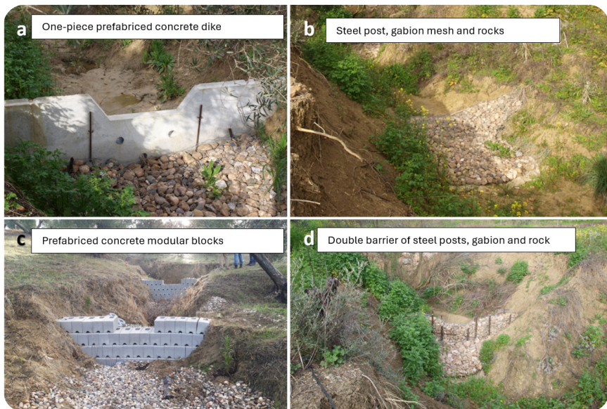
Abb. 1: Schutz der Gullydämme mit unterschiedlichen Bautechniken.techniques.
