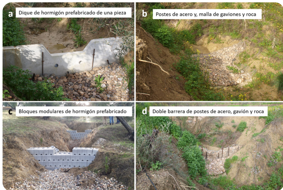
Fig. 1: Diques de control de cárcavas con distintas técnicas constructivas.
